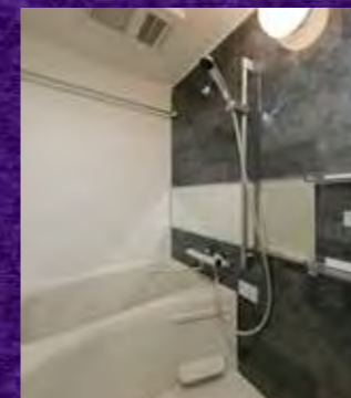
バスルーム/1K (1014) (施工写真)
