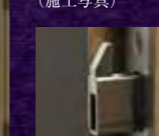
鍵付デッドボルト (施工写真)
