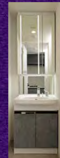
洗面化粧台/1K (施工写真)
