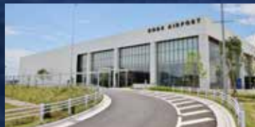
神戸空港第2ターミナルビル
